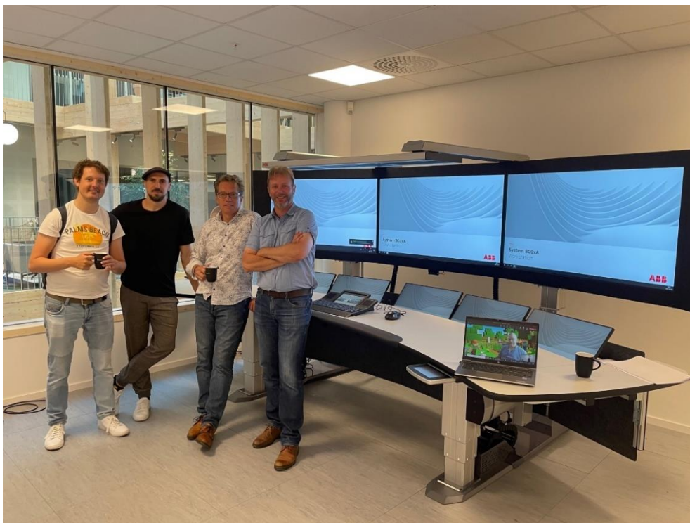
Figur 9, EOW installerat och redo för användning i ROC rummet, Färjerederiet Solna
